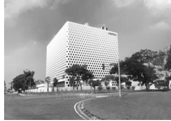
Toàn cảnh tòa nhà Trung tâm dữ liệu của Viettel tại Hòa Lạc.
